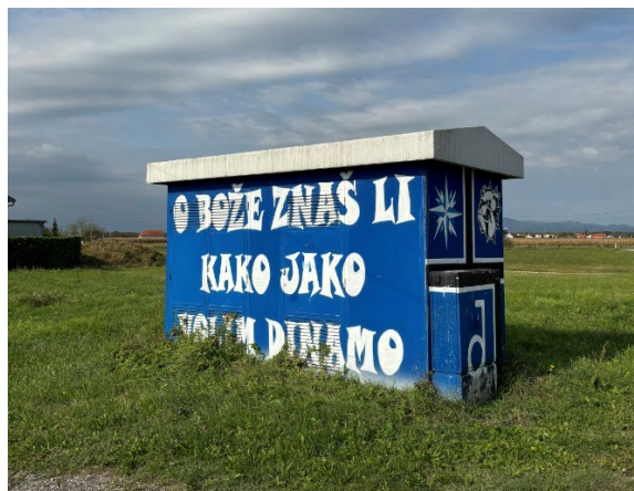
Slika 11. Trafostanica Hudi Bitek (2) u Pekarskoj ulici
